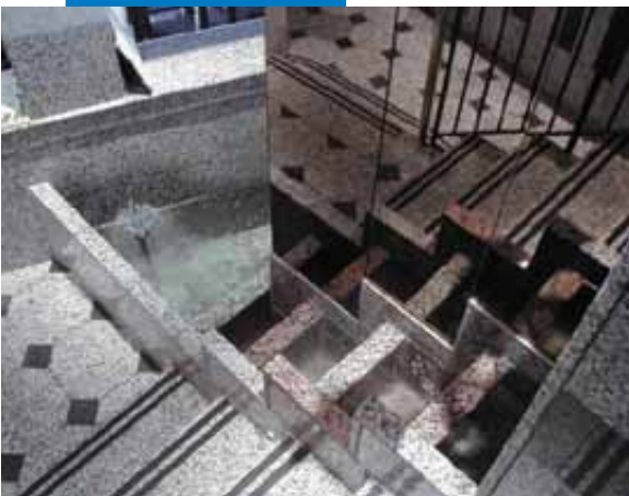
Esempio di posa di granito a parete e pavimento con Keraquick + Latex Plus - Caesaris Palace a Merseyside - Liverpool (Gran Bretagna)
